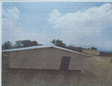
Techo nuevo en dos aulas y Direccion
